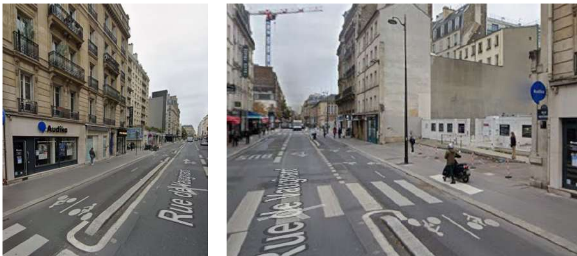
Photo de la rue de Vaugirard et des travaux d'aménagement cyclables avant livraison.
