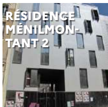
109-111 rue de Ménil- montant 75020 Paris
