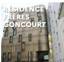
117 rue de Ménil- montant 75020 Paris
