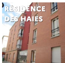
RÉSIDENCE DES HAIES 72-74 rue des Haies 75020 Paris
